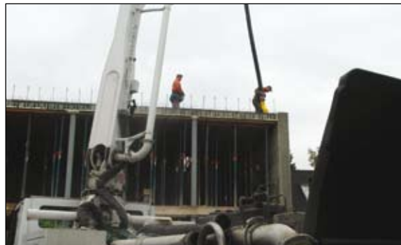
Práce s betonovým čerpadlem
