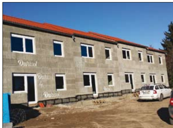
Řadové RD Jinočany
